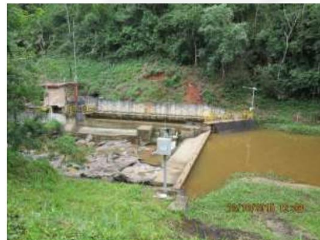
Foto 01. Barragem da PCH Cachoeira do Brumado
