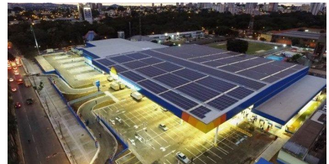
Usina solar urbana - exemplificativa
