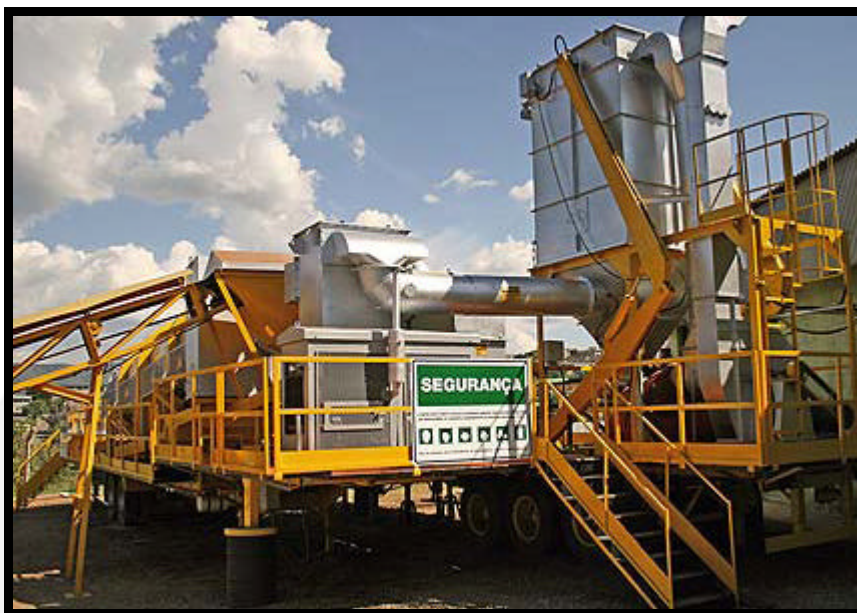
Foto 1: Plataforma de incineradores com fornos rotativos construída e operada pela Ecobrás no Estado do Rio Grande do Norte.
